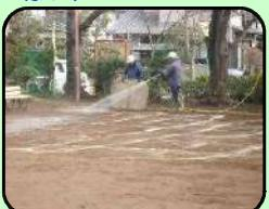
※ 降雨毎に浸透改良します。整正転圧後BP散布後「コーンα」液散布で完了。効果は浸透と共に発揮します。
