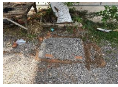
雨対策保護碎石層設置完了
