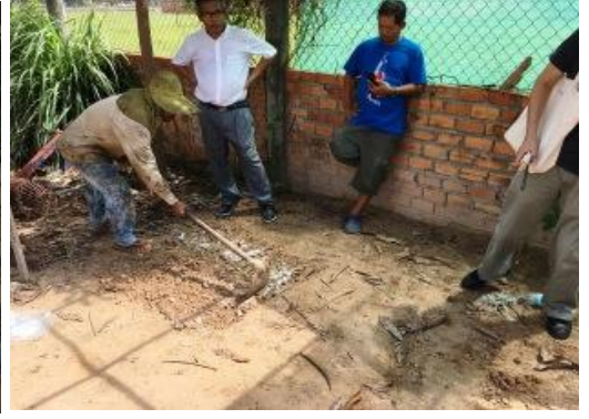
攪拌均し転圧状況
