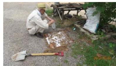
雨対策保護碎石層設置完了
